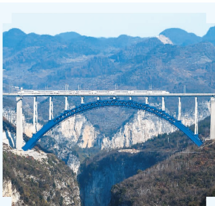
一列动车组列车从成贵高铁西溪河大桥上驶过。
