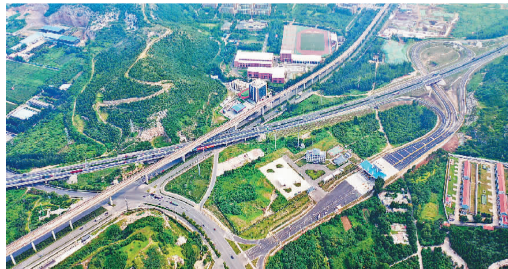
8月18日，由中建路桥集团山东分公司承建的济广高速长清大学城互通立交项目正式建成通车。该项目采用匝道下穿主线的A型单喇叭方案，总占地21公顷，总投资1.5亿元。项目建成后将优化长清区乃至济南市交通路网结构，推动省会城市群经济圈建设。图为济广高速长清大学城互通立交航拍全貌。
