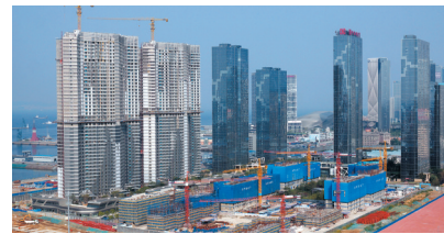
大連市對市內五區新房採取五年限售措施。圖為大連市某在建樓盤。記者宋偉 攝
