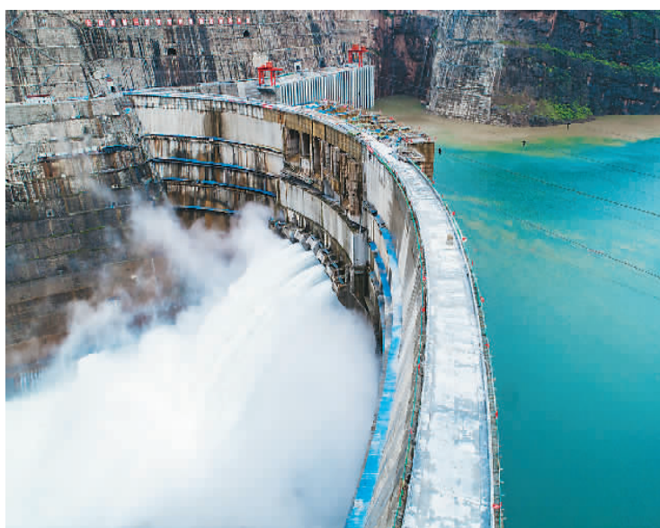
白鹤滩水电站大坝坝面。
