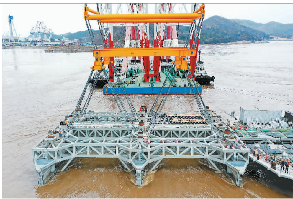
LHD海洋潮流能发电项目第四代1.6兆瓦机组正在安装，预计今年10月下海并网运行。
