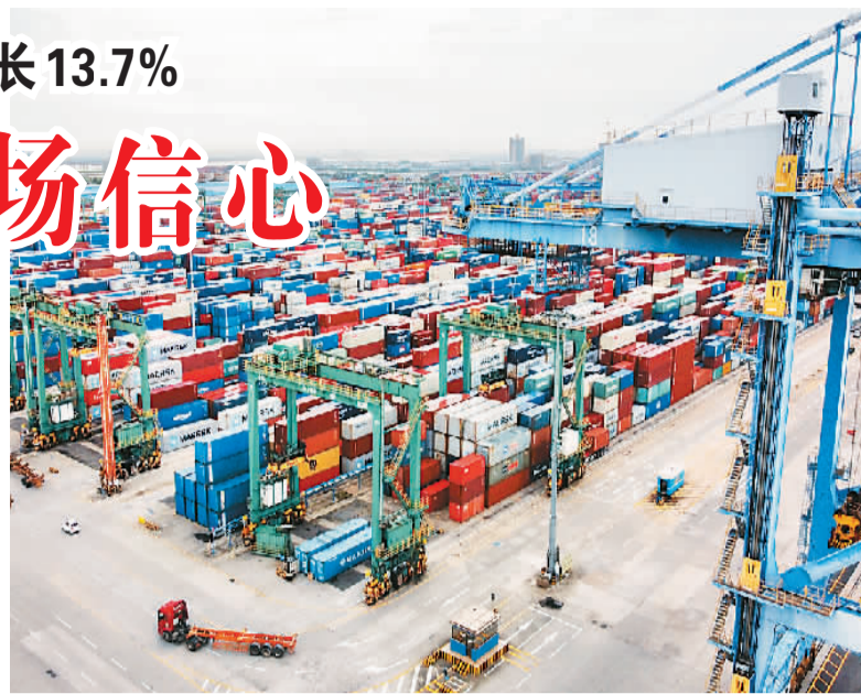
近年来，广东省广州南沙港加强基础设施建设，逐步打造成南方重要的物流配送基地。2020年南沙跨境电商网购保税进口额达188.2亿元人民币，占全国业务量的五分之一。图为广州港南沙港区码头堆场。新华社记者 耿馨宁摄
