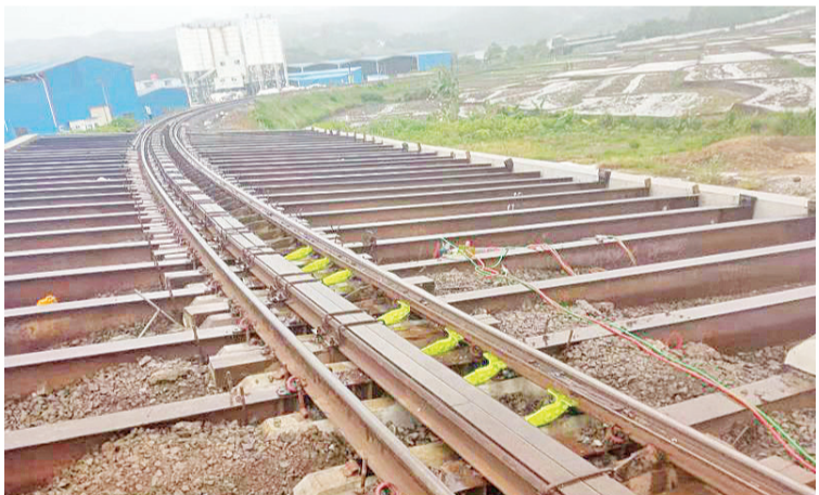
既有铁路加固
