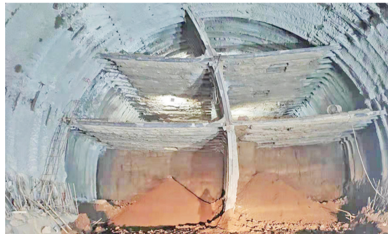
洞内CRD施工
