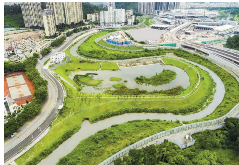
▲深港聯合治理深圳河工作小組所建築的蓄洪湖泊佔地22000平方米。(渠務署提供)
