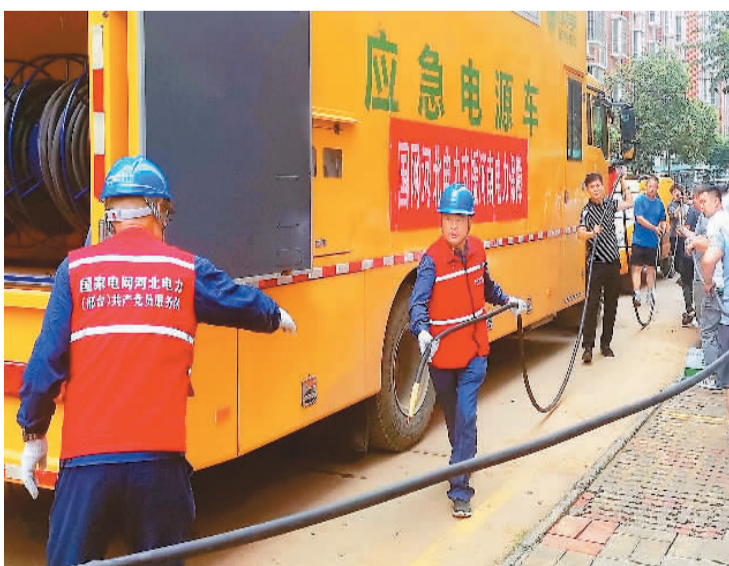
国家电网河北邢台供电公司近日选派119名精干力量，分配1台发电车、23台发电机及急需物资分批驰援河南郑州、焦作、新乡等地，争分夺秒抢修电网设备，助力河南早日全面恢复正常供电秩序。图为援豫邢台分队队员在抢修线路。马千里摄（人民视觉）
