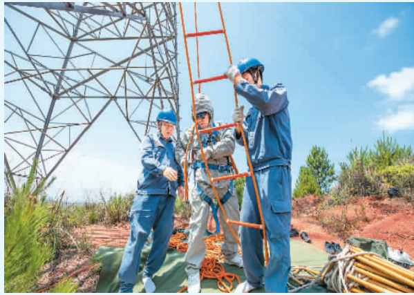
南方电网广西梧州供电局对220千伏洲翠线4号杆塔线缺陷开展等电位带电作业，助力西电东送。何华文摄（人民图片）
