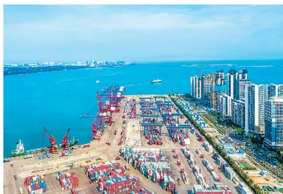
海南省海口市海口港集装箱码头智能闸口系统近日上线运行,提高了码头智能化水平和作业效率。智能闸口系统上线以来,车牌识别率达99.59%,挂车牌识别率达99.44%,平均每辆车通过时间为13.69秒。图为海口港集装箱码头的繁忙景象。石中华摄(人民视觉)
