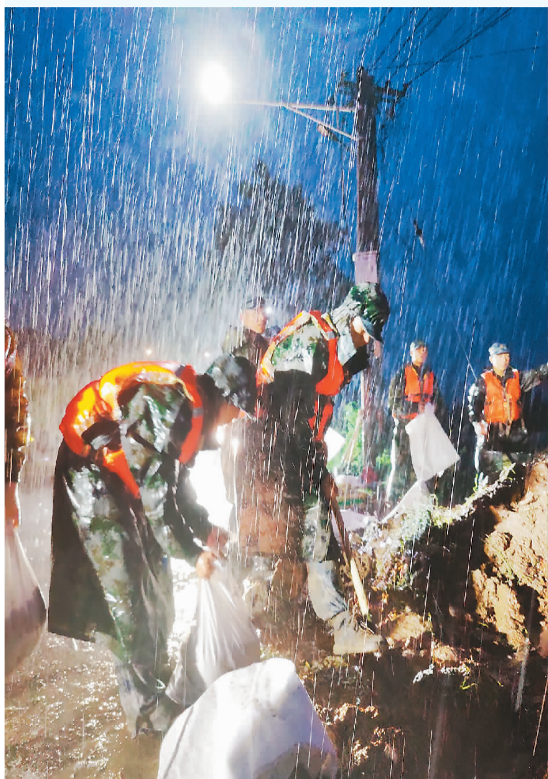
七月二十一日,驻扎在河南开封地区的空降兵某旅官兵冒雨在贾鲁河祥符区段加固堤坝。 李志伟摄(新华社发)
