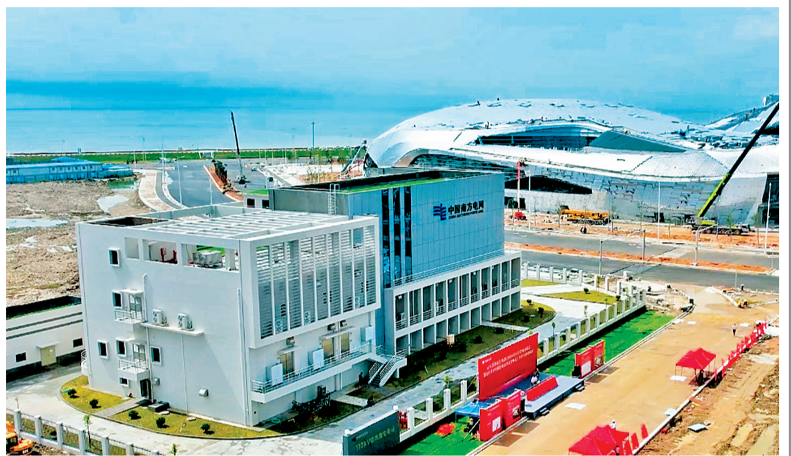
110千伏塔崗圍輪變電工程(前)順利竣工。
