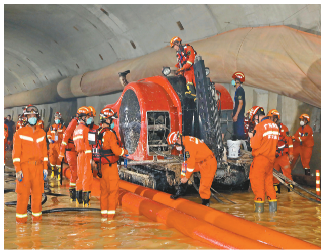
救援人員進行排水作業。
