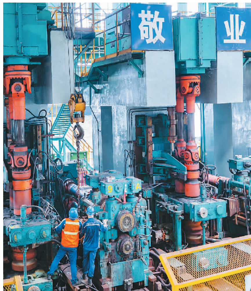
近日，中国宝武马钢股份特钢公司生产一线的工人们冒着高温维护设备。
