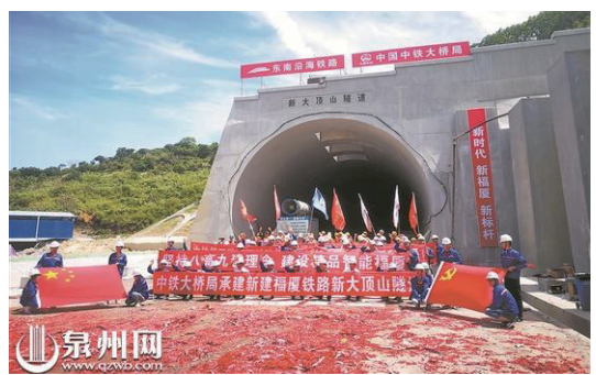
福廈高鐵正綫隧道全部貫通
