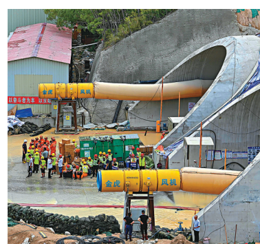
●珠海海事隧道工地救援現場。中通社
