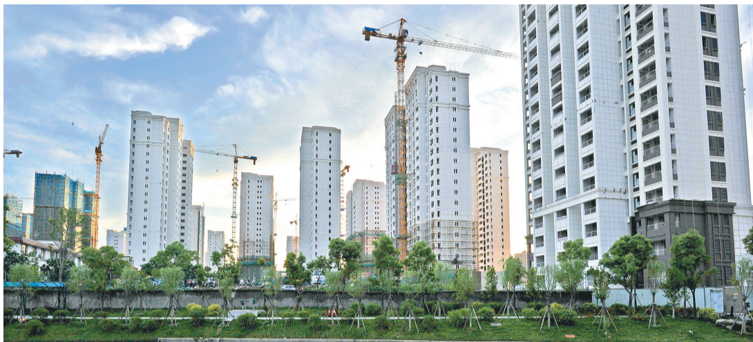
圖為福建福州一處開發建設中的房地產樓盤。中新社 98900元/㎡，而最新成交均價已經降至77240元/㎡，降幅約20000元/㎡。
