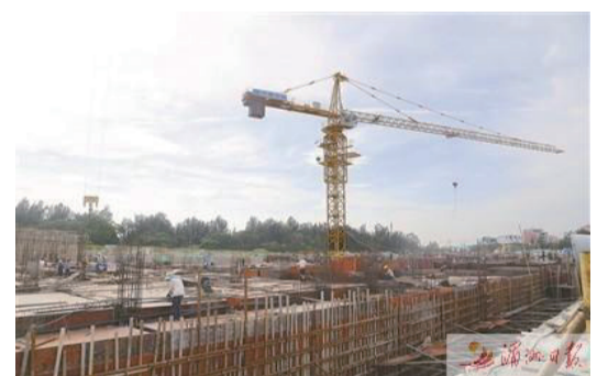
圖為媽祖醫學院項目建設現場。
