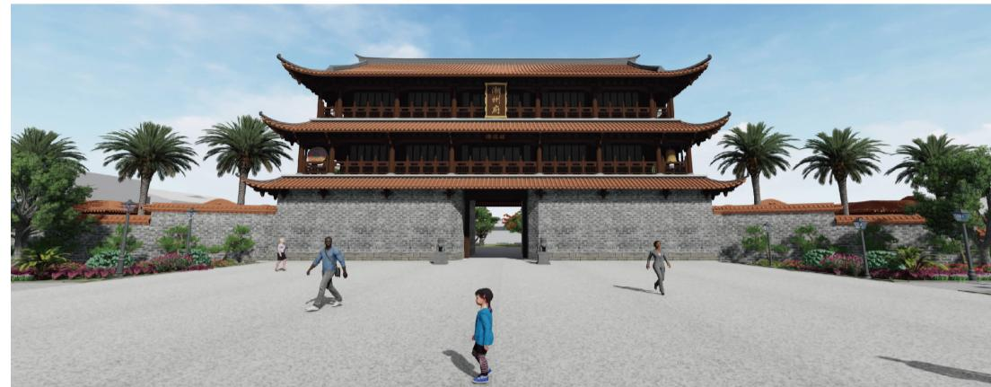
道路及排水、綠化、監控及照明等工程。復建的鎮海樓根據清末原貌老相片，按明代傳統譙樓建築仿古設計，坐北朝南，共三層，總建築高度 19.08 米，
