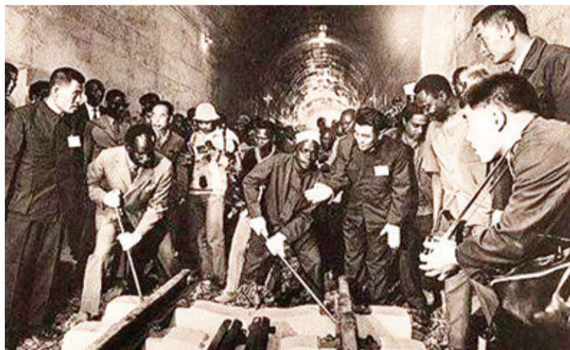
中非工人共同修铁路
