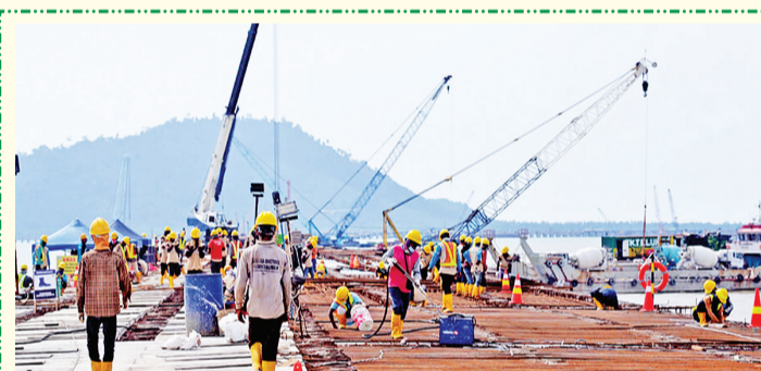
山口洋附近的万吨级基让(Kijing)国际码头正加紧建设。
