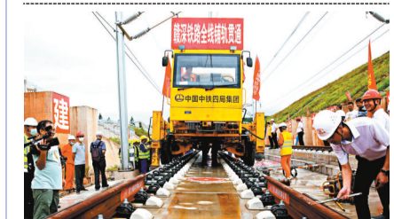
贛(州)深(圳)高鐵廣東段與江西段12日成功接軌(圖)，標誌著贛深高鐵全線正線軌道鋪設完成。全線預計於2021年年底建成通車，屆時，贛州至深圳的通行時間將由現在的7小時縮至2小時。 ●記者郭若溪 深圳報道
