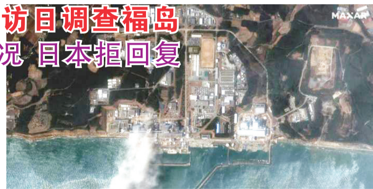
2011年3月14日,日本福岛第一核电站在地震后的受损情况。
