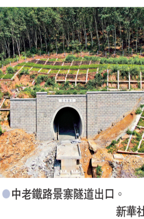
●中老鐵路景寨隧道出口。 新華社
