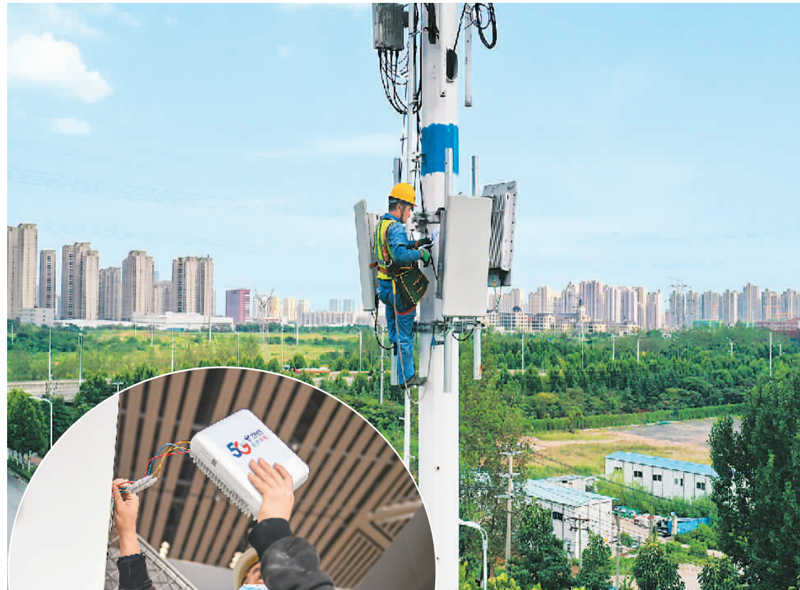
▲在安徽省合肥市蜀山区大别山路与鸡鸣山路交口附近，塔工在铁塔高处安装5G信号设备。 陈三虎摄（人民图片）
