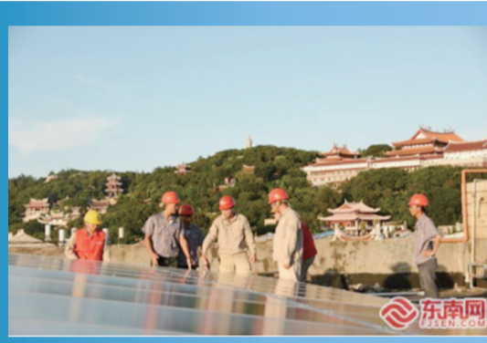
國網湄洲島供電公司員工服務東蔡村光伏發電項目并網。(魏清水 攝)
