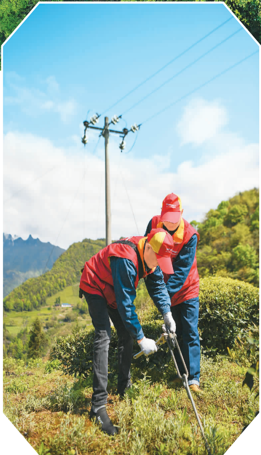
▲ 壶瓶山供电所的工人在壶瓶山镇管山村巡线。
