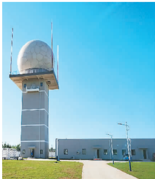
北京大兴国际机场的C波段全数字有源相控阵天气雷达。
