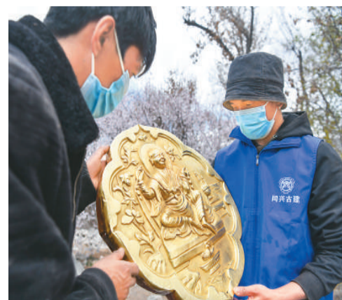
图为维修人员检查刚刚安装完的装饰件。新华社记者 晋美多吉摄
