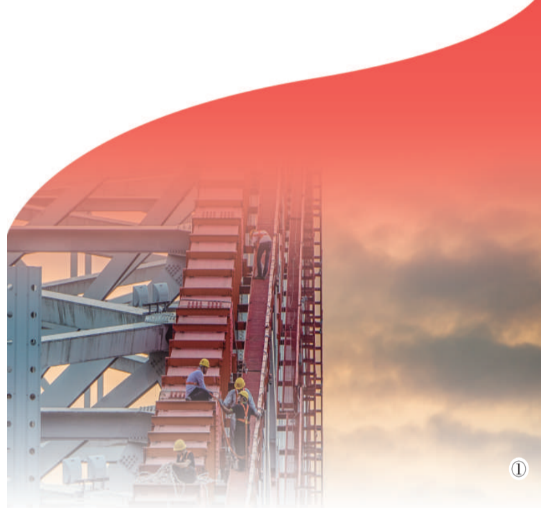
图①:2020年9月4日,工人在重庆朝天门长江大桥桥梁主体钢架上施工。龙帆摄(影像中国)
