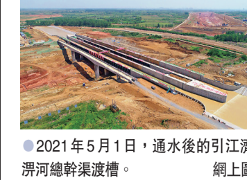
●2021年5月1日，通水後的引江濟淮滌河總幹渠渡槽。網上圖片
