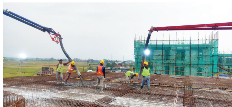
混凝土浇筑
