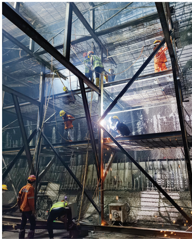
坚守施工一线的劳动者
