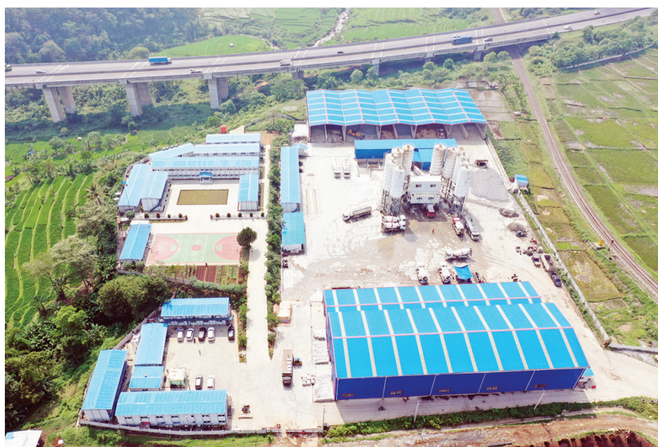
项目部驻地航拍
