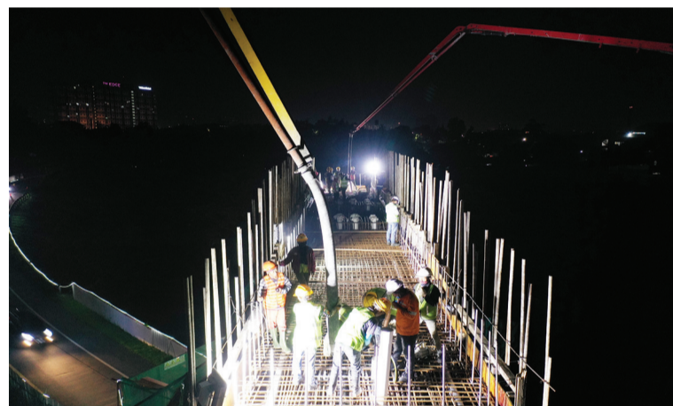
钢筋混凝土桥墩，预应力混凝土横梁高3米，跨度24米。本次施工的的门式墩墩高10米，
