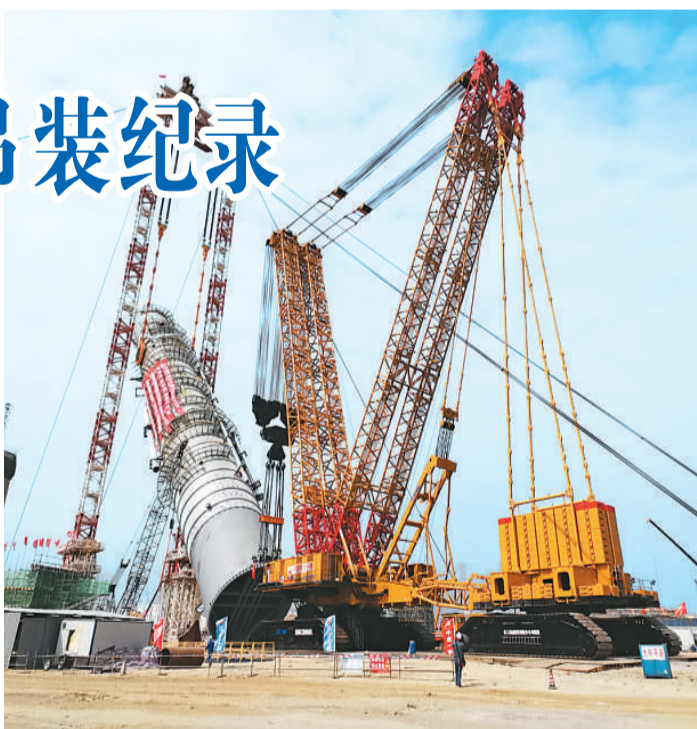
正在进行吊装的抽余液塔。 本报记者 王俊岭摄
