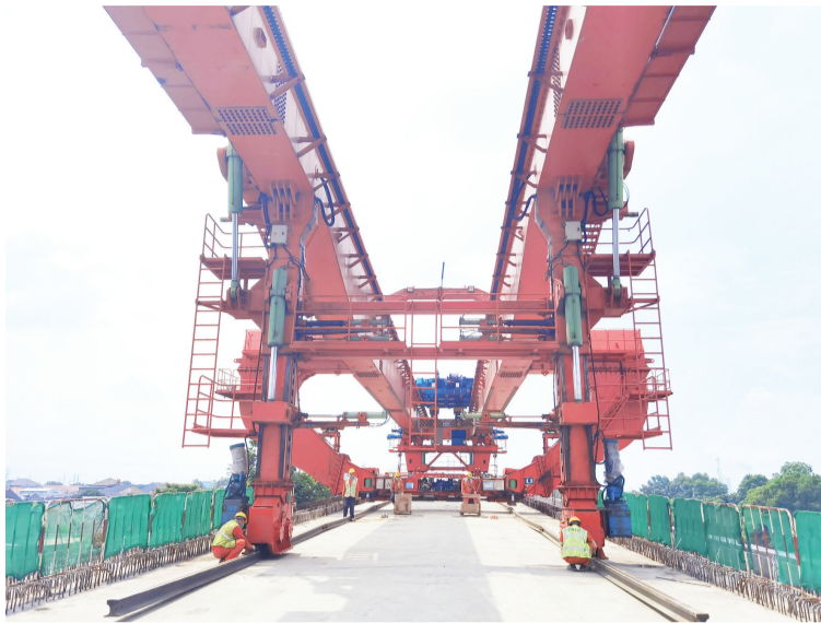
架桥机大坡度过孔
