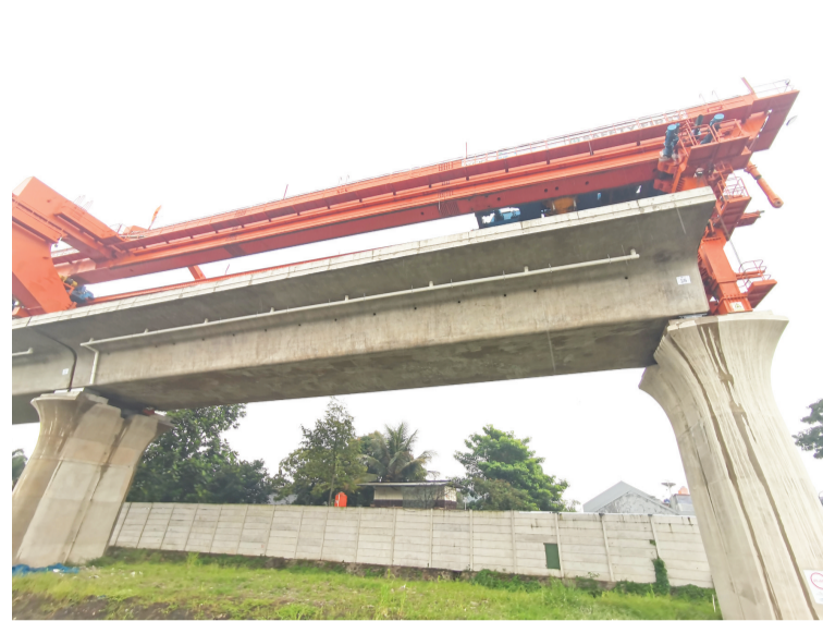
大坡度箱梁顺利架设完成
