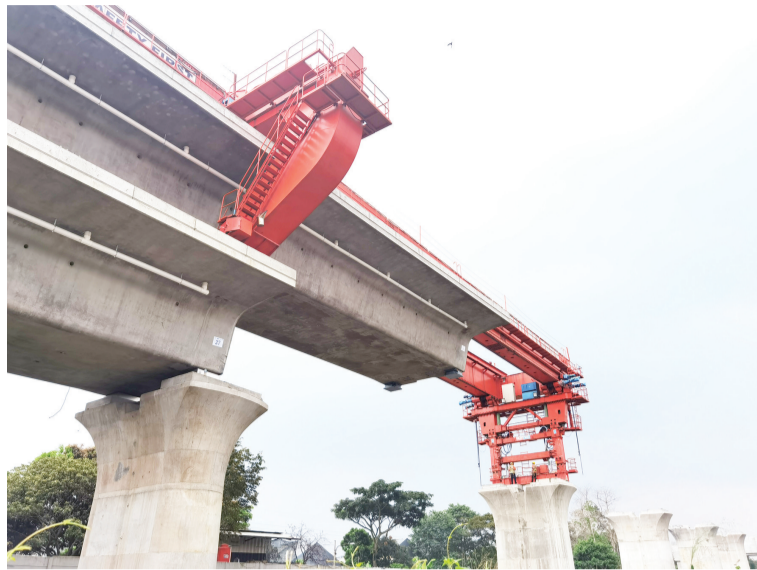
大坡度箱梁架设中
