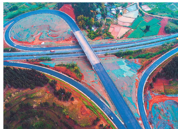
日前,由中建路桥集团承建的四川绵阳至遂宁高速公路龙凤互通立交主体主体工程完工。绵遂高速是成渝环线高速的重要组成部分,也是四川南向出川(至重庆、广东)大通道的重要路段。 颜 雄摄
