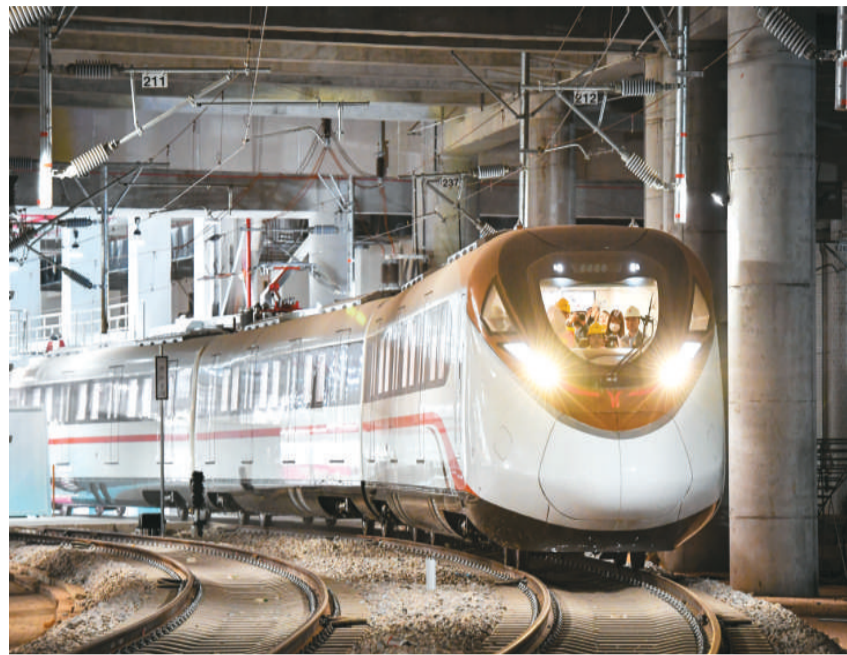
广州地铁18号线时速160公里的电客车在进行热滑试验。新华社记者 刘大伟摄
