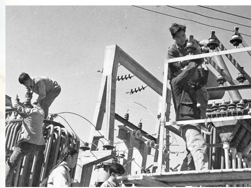
●1964年4月，東深供水工程建設現場。 資料圖片
