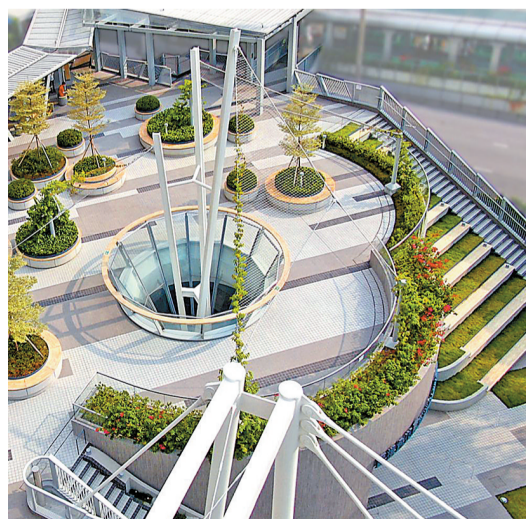
荃灣西樓角花園重建，把半個公園「升高」為平台花園。
