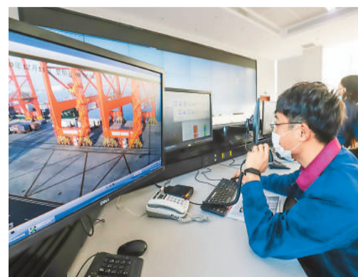
工作人员在河北唐山港智慧码头控制中心进行远程操控作业。 刘满仓摄(人民图片)
