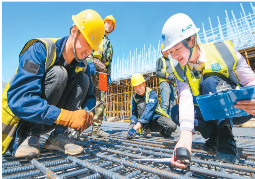
4月16日，一场劳动技能竞赛在新疆乌鲁木齐机场改扩建工程现场举行，参赛选手大显身手比拼技能，比赛现场热火朝天。劳动竞赛涉及安全生产、工程质量、工程进度等建设项目重点工作。图为来自中建三局的施工人员参加钢筋绑扎比赛。新华社记者 王菲摄
