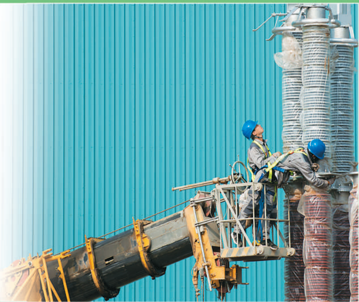
▲在张北柔性直流电网±500千伏康保换流站工程现场，施工人员正在吊装桥臂电抗器。 邹明摄
