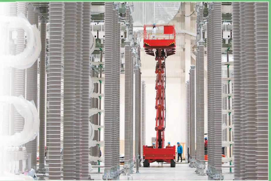
▲在张北柔直换流站阀厅内，施工人员正在安装塔网的模块。 邹明摄
