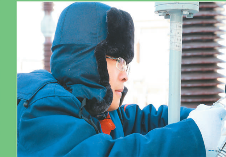
▲国网冀北检修公司职工李振动在500千伏北京环网变电站停电检修现场。 刘洁摄
