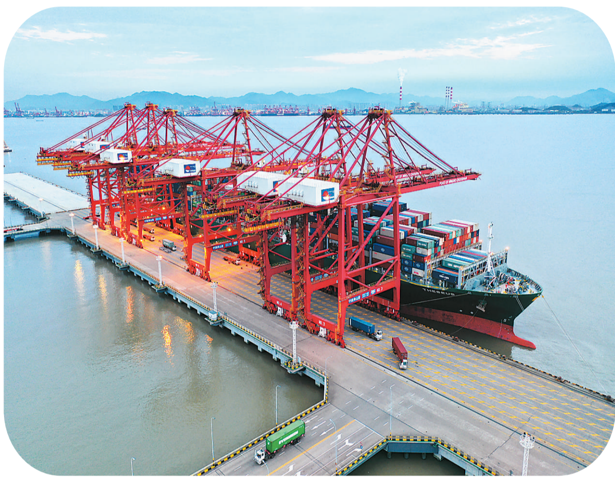
四月六日，在浙江宁波舟山港金塘港区大浦口集装箱码头，一艘集装箱船正在卸货作业。
