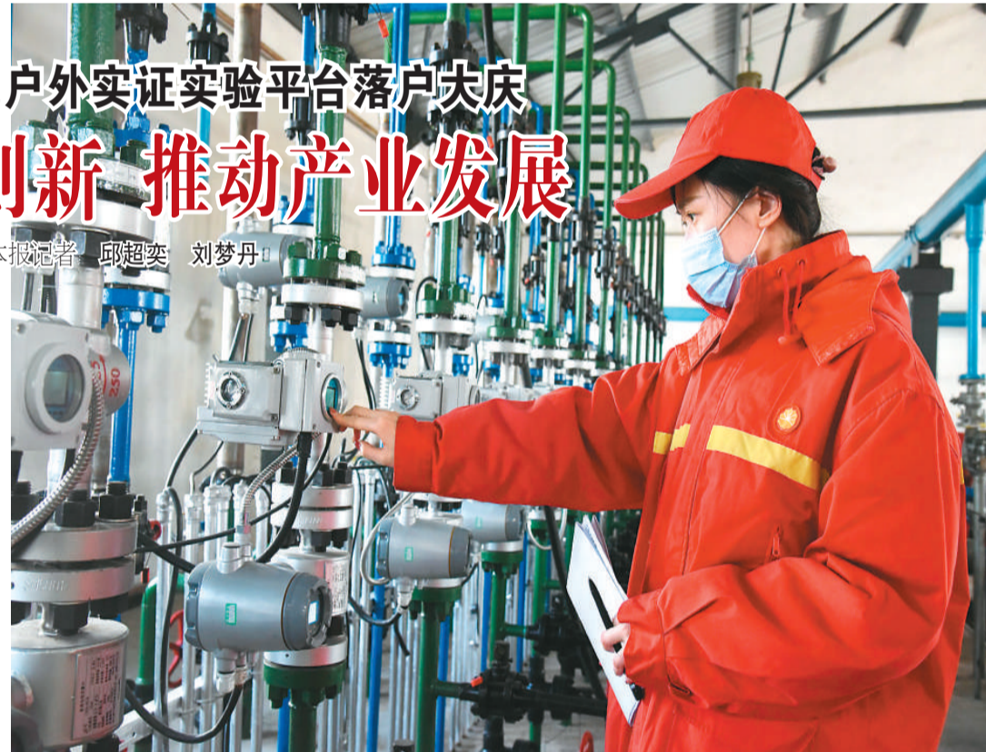
日前，在大庆油田第二采油厂第七作业区南三东三元转油配注试验站，工作人员在记录数据。
