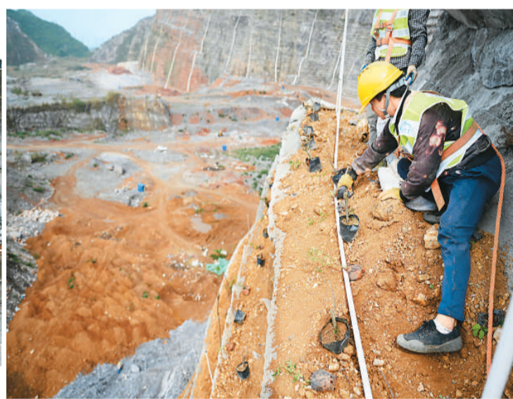
▲ 工人在作业平台上整理泥土、摆放树苗。
