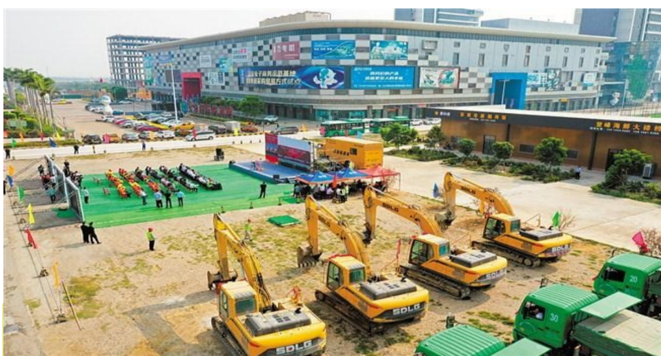
汕頭市在設于澄海區六合現代產業示範區基礎設施建設項目現場的汕頭分會場,收看收聽2021年首季度廣東省重大項目集中開工儀式。
