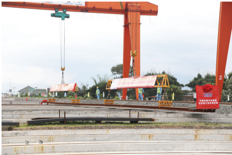
钢轨吊装转运
