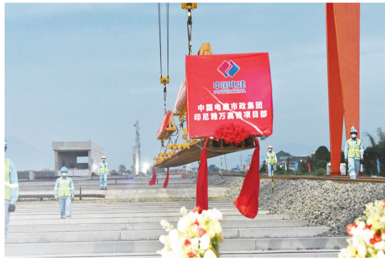
钢轨运抵卡鲁尔动车所铺轨基地
