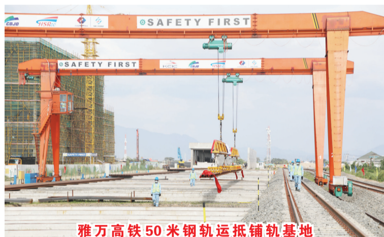
雅万高铁50米钢轨运抵铺轨基地
