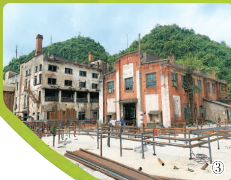
③柳州在工业历史保留建筑内开展原位热脱附修复污染土壤。资料图片
