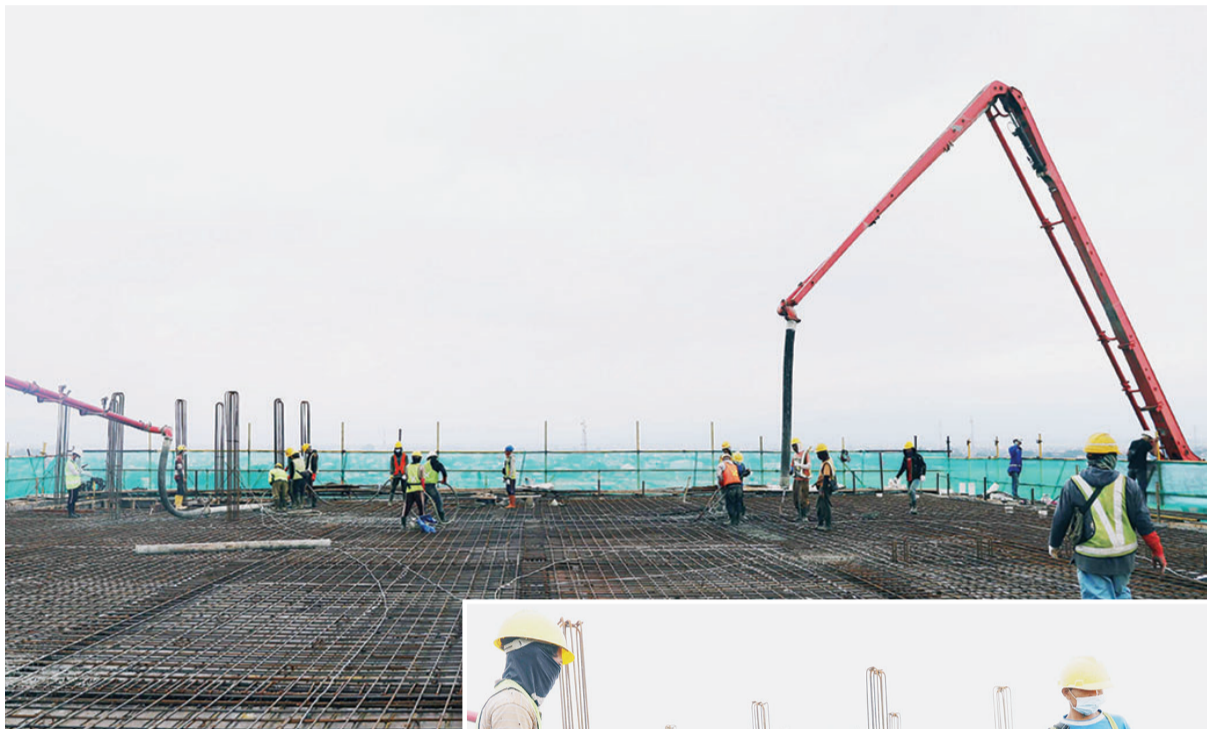
动车组站房综合楼 A 楼封顶浇筑
