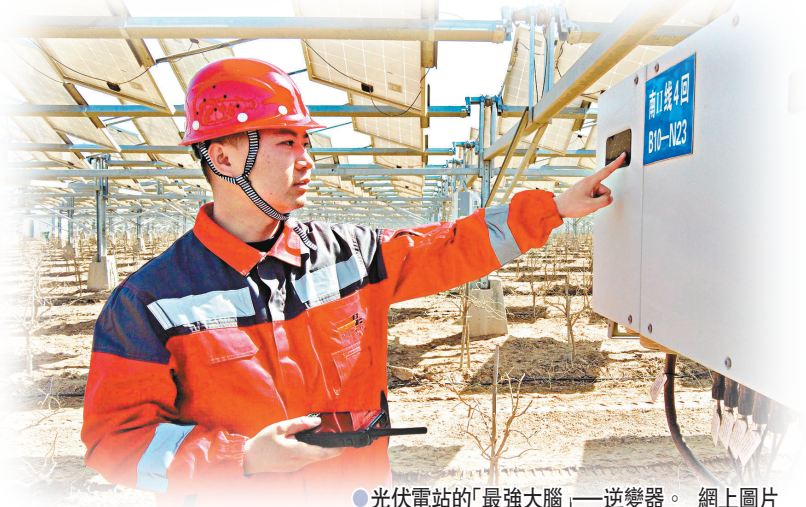
光伏電站的「最強大腦」——逆變器。網上圖片
